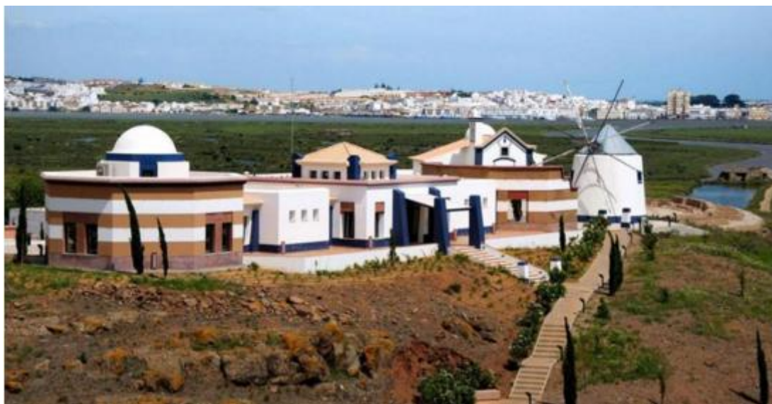
Figura 11 – Vista geral do revelim de Santo António
